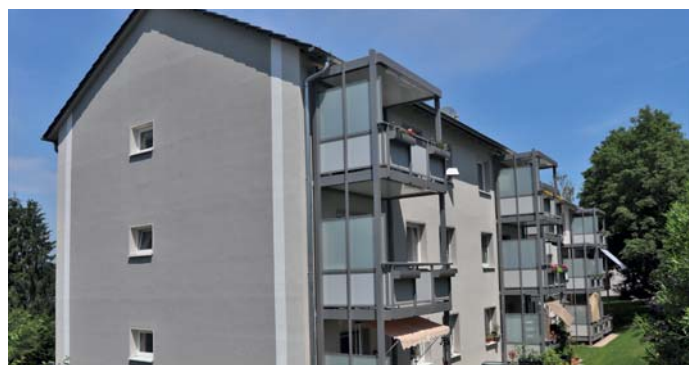
Aluminiumfertigteilebalkone Phönixstraße 35-35c
