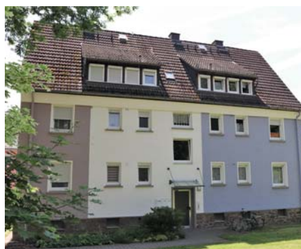
Stellplatz für gelbe Tonnen (l.) und Fassadenanstrich Bredowstraße 14. (r.)
