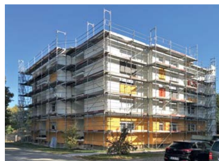
Fassadenmodernisierung Hohe Straße 28
