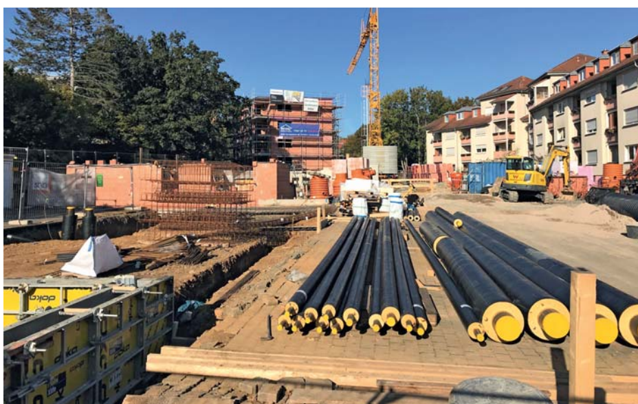
Baufeldübersicht mit Nahwärmeleitungen Schwalbengraben 118–120
