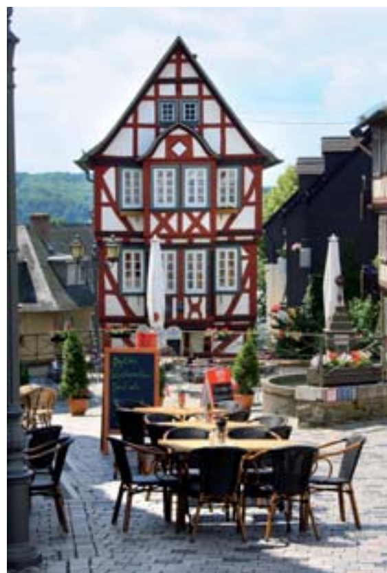
Gepflegtes Schmuckfachwerk: Auch ein Beitrag der WWG zur Altstadtsanierung
