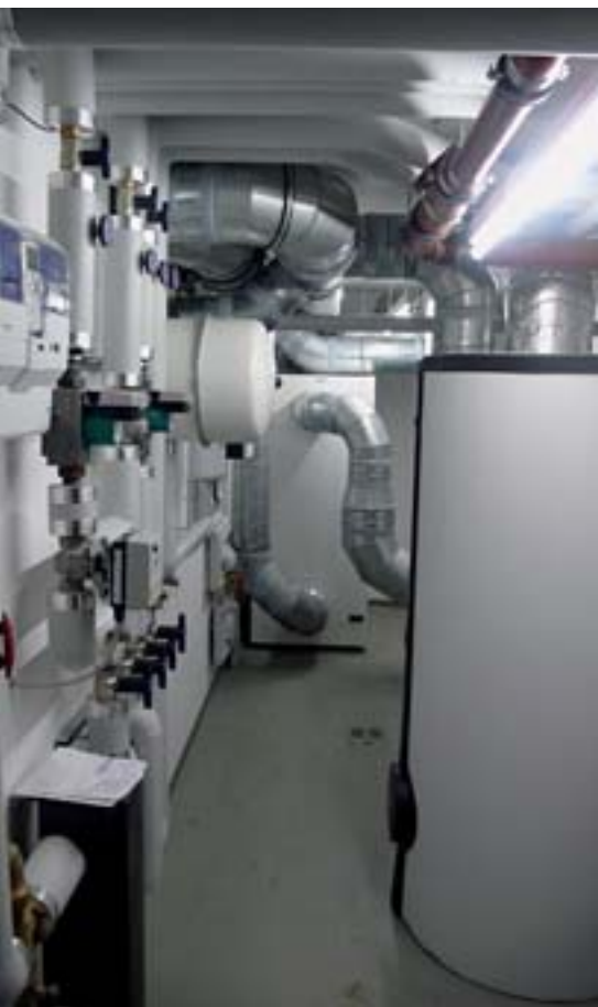
Hightech Heiz- und Lüftungszentrale: Passivhaus, Waldgirmeser Straße 24
