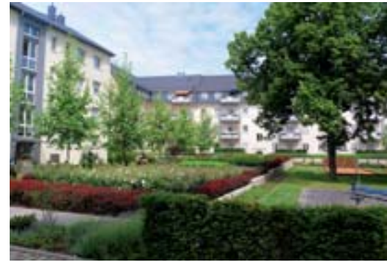
Zu einem Schmuckstück von südländischer Eleganz geworden: Das Wohnquartier Kirchstraße 2 – 14, Georg-Lauber-Straße 1 – 3, Silcherstraße 5 – 7
