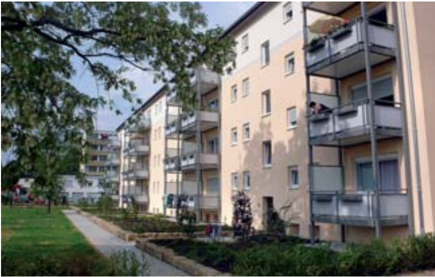
Neu angeständerte Balkone in südwestlicher Ausrichtung eröffnen neue Perspektiven des Wohnens: Im Winkel 21 – 25
