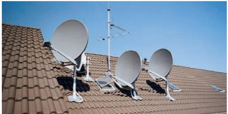
*Satellitenkopfstation auf dem Dach des Gebäudes Im Winkel 10: Sie ermöglicht für etwa 320 Wohneinheiten fast grenzenloses Fernsehen. Satellitenschüsseln auf den Balkonen gehören damit der Vergangenheit an.*
