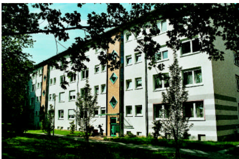
Blickfang sind neu aufbereitete und gestaltete Treppenhäuser: Am Sturzkopf 1 – 3
