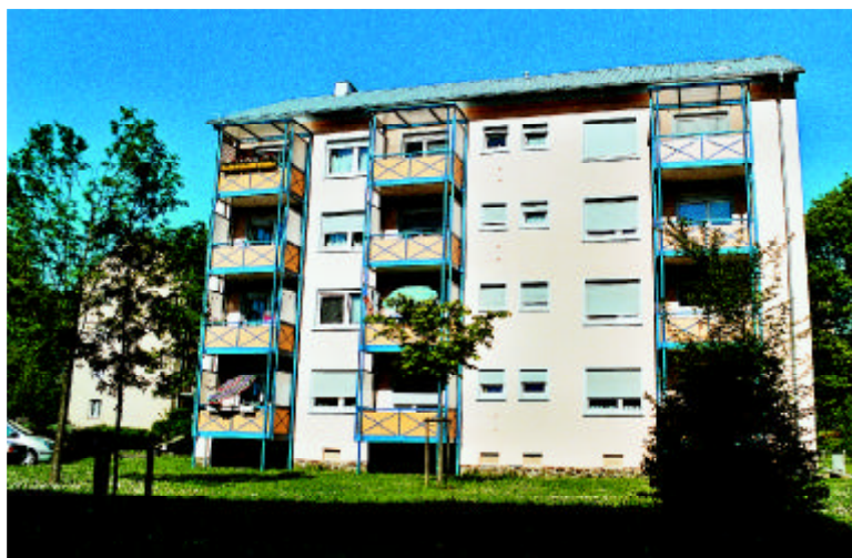
Vorgeständerte Balkonsysteme als Gestaltungselemente. Farbenfrohe Balkone verschönern die Fassade der Volpertshäuser Straße 5
