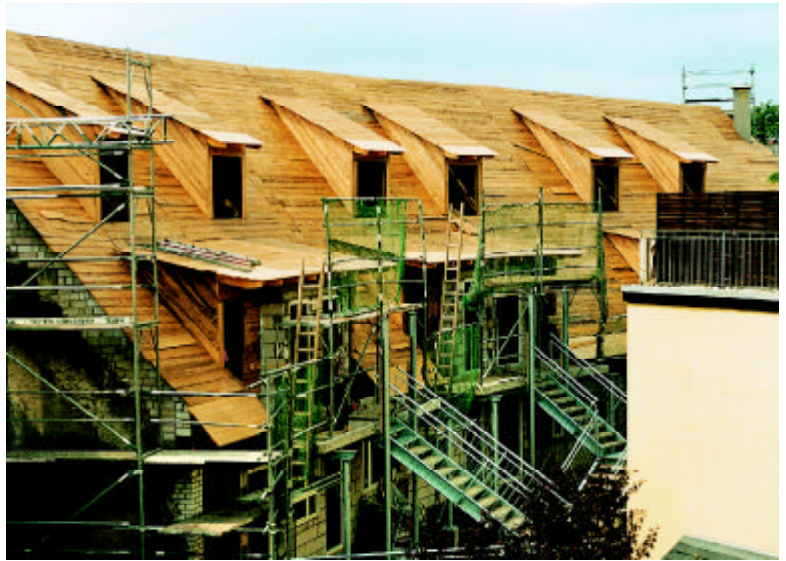
Ohne traditionelle Werkstoffe geht's nicht: Fertigstellung der Dachschalung samt Schlepplgauben
