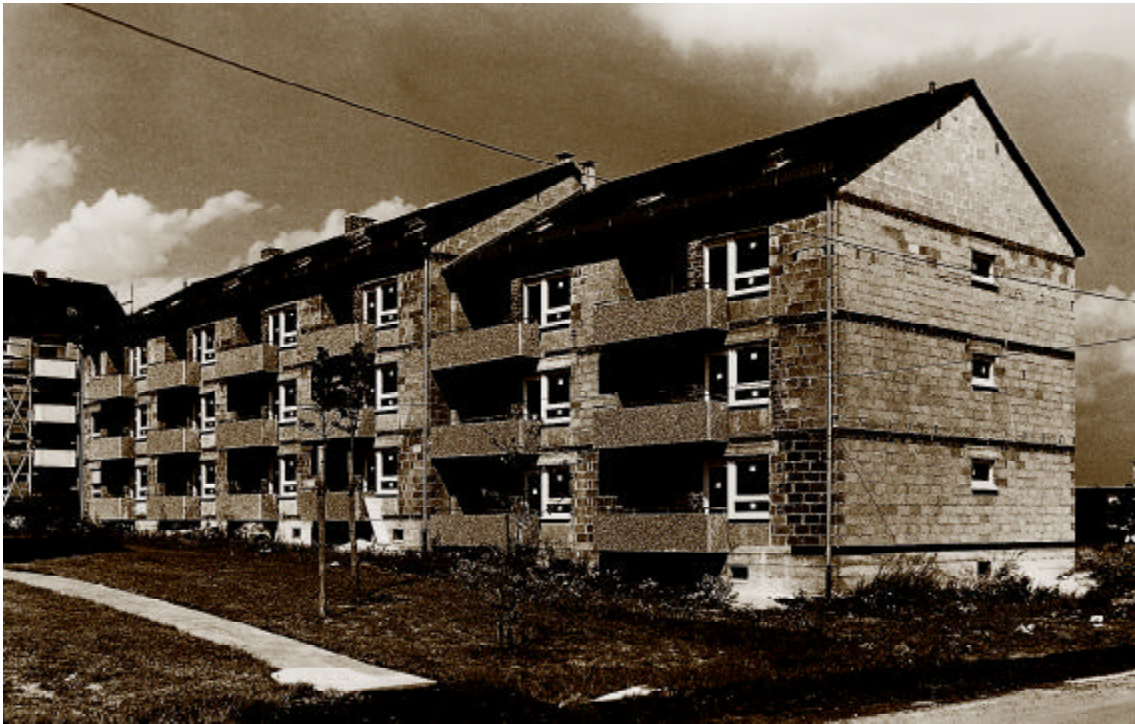
Auf solider Handwerksarbeit – auch traditionelle Bauweise genannt – gründet der gute Ruf der WWG, ob in der Errichtung von Miet- oder Eigentumswohnungen: Wetzlar-Dalheim, Drei Stämme 4 – 8
