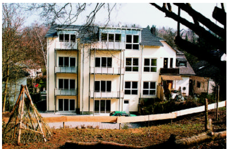
Ansprechende Freisitze sind heute Standard: Zur Verbesserung der Wohnqualität erhielt das Gebäude Philosophenweg 36 eine »geständerte« Balkonkonstruktion
