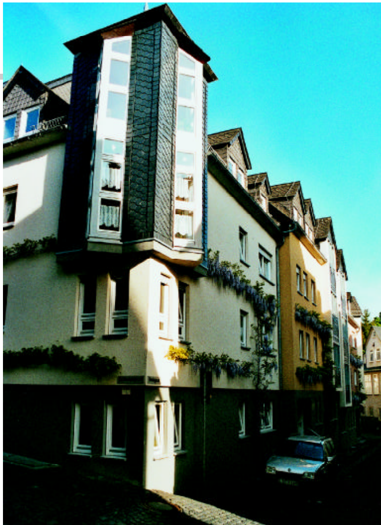
Im Mittelpunkt einer ansehnlichen Fassadengestaltung: Mit Schiefer »eingekleideter« Erker an der Ecke Scheunengasse/Rosengasse
