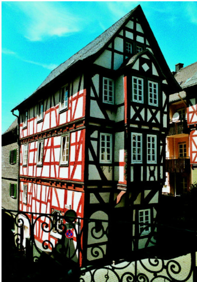
Maßstabsgetreu saniert: Das Haus Engelsgasse 2 prägt das Bild des Kornmarktes mit Hausinschrift:
