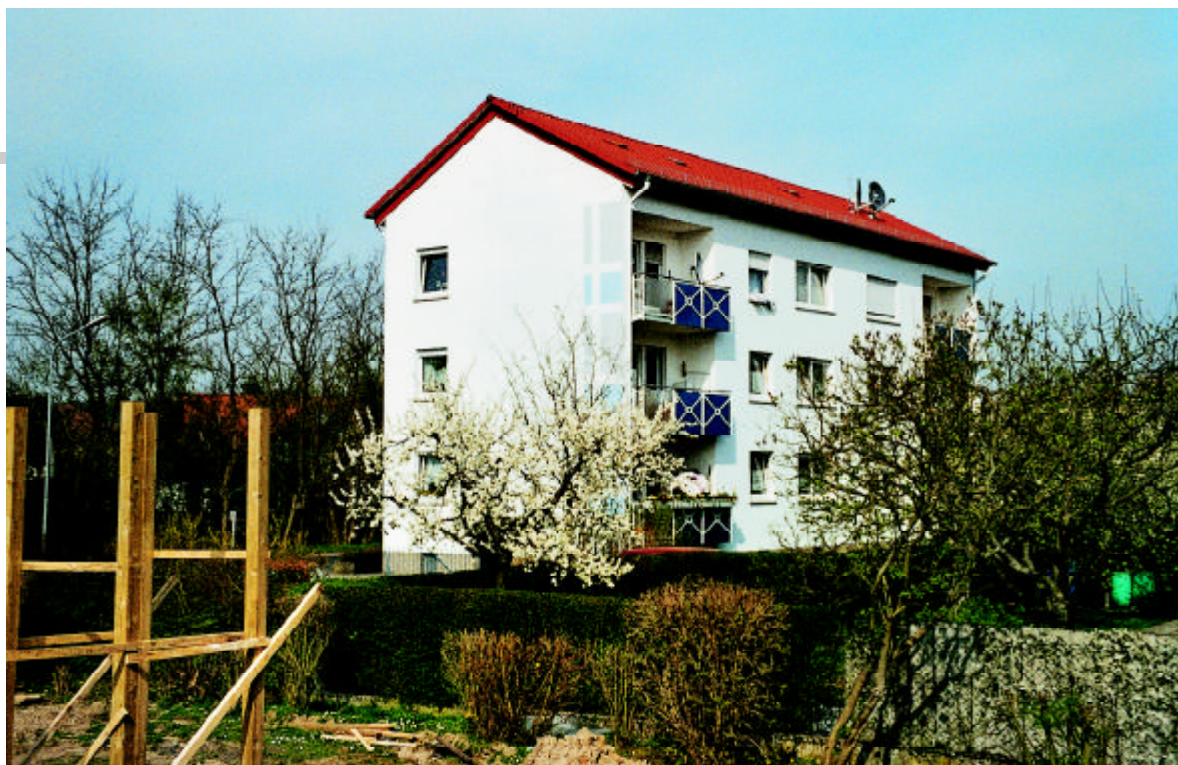
Von schlicht zu anspruchsvoll – die Metamorphose eines Gebäudes in Atzbachs Büchnerstraße 9
