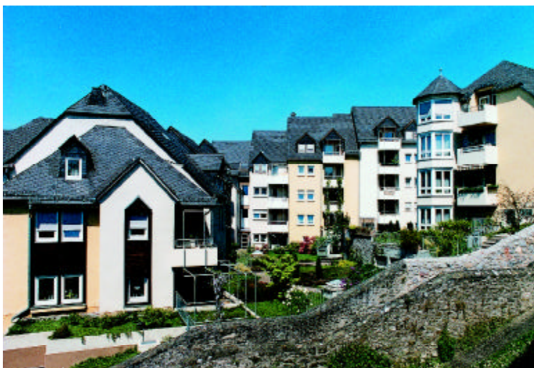
Angewandte Stadtbildpflege beim Neubau Rosengasse 13 – 15, Scheunengasse 1 und Jäcksburg 18/20; hier stand die ehemalige »Puddingschule«
