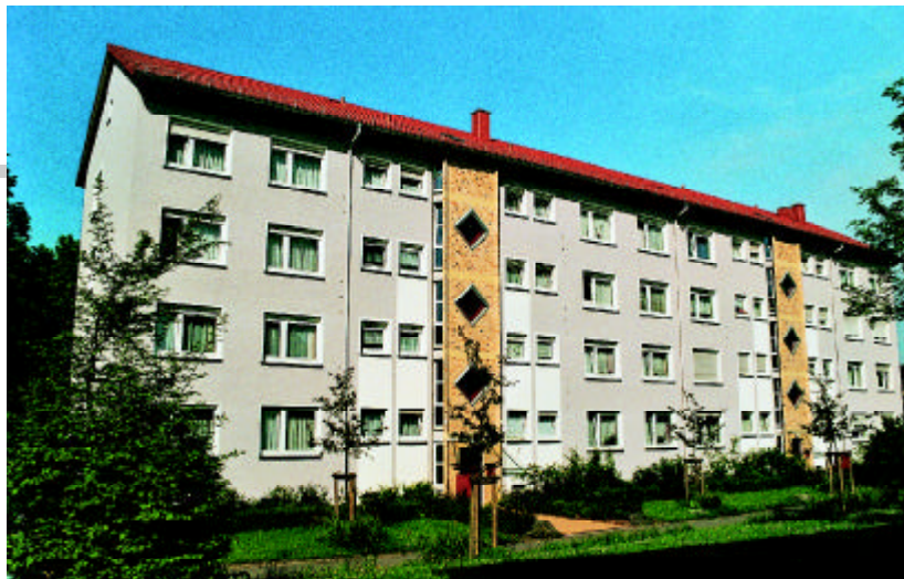
Harmonisch abgestimmtes Farbkonzept und umfassende Veränderungen in der Außenanlage verbessern das Wohngefühl in der Liegenschaft Am Sturzkopf 7 – 9
