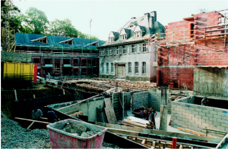
Vorübergehender Stillstand auf der Baustelle: Nach Insolvenz musste für den Rohbau ein neuer Auftragnehmer gefunden werden
